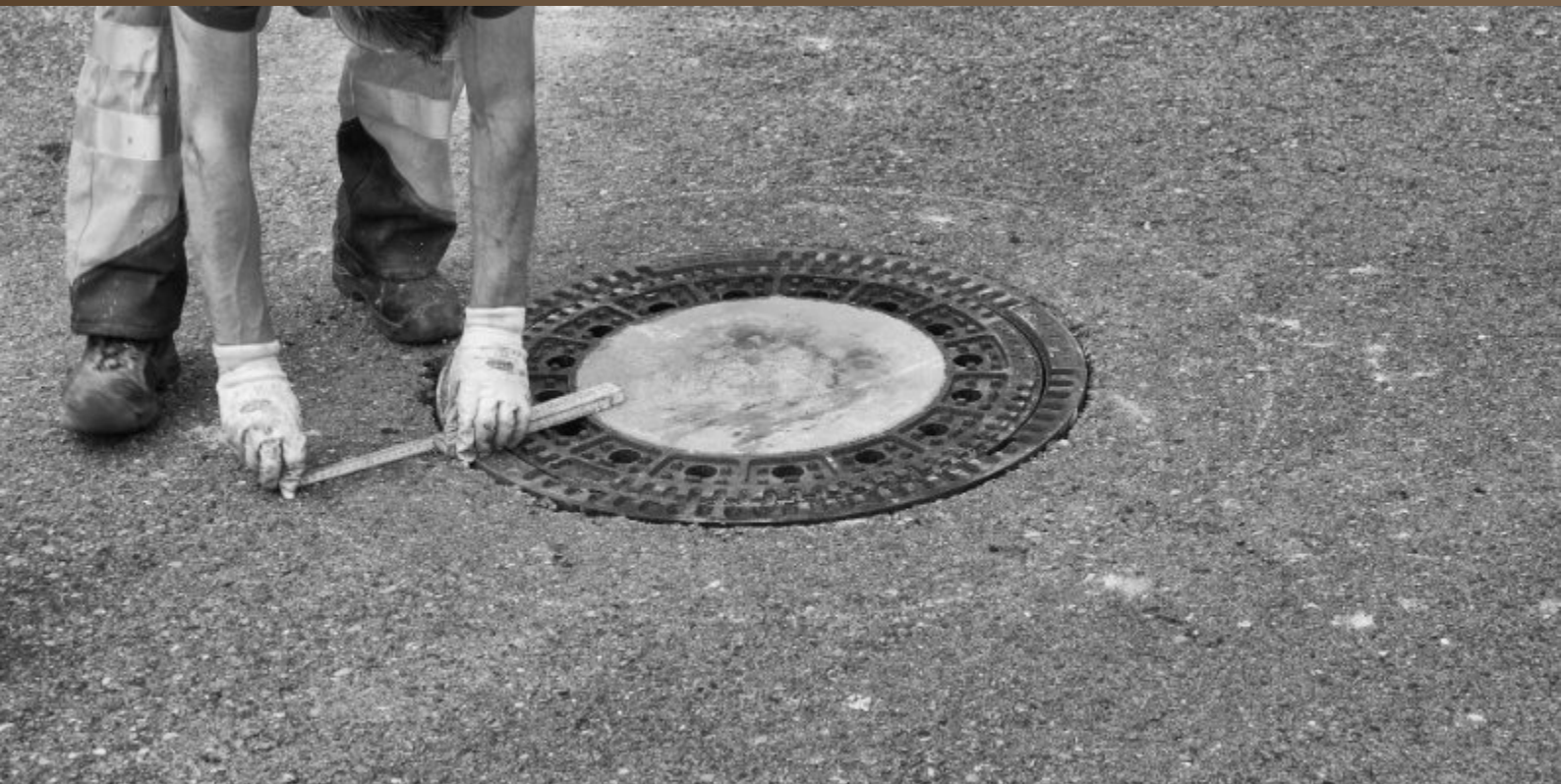
Schachtrahmen-Neueinbau mit Asphalteinbau
