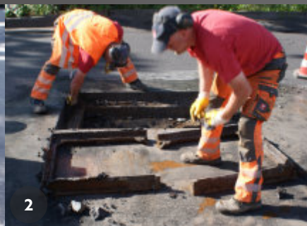
Schachtrahmen-Neueinbau/Reihenabdeckung
