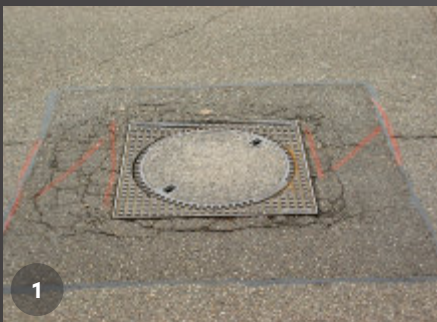
Regulierungen/Asphalt fräsen
