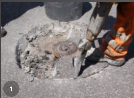
Schieberkappen-Neueinbau
