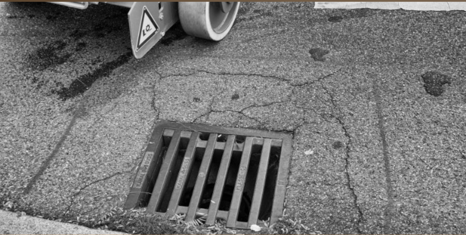
Straßenablauf/Regulierung inkl. Asphalteinbau
