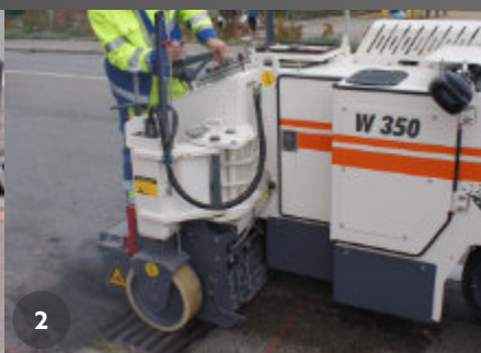
Straßenablauf/Regulierung inkl. Asphalteinbau
