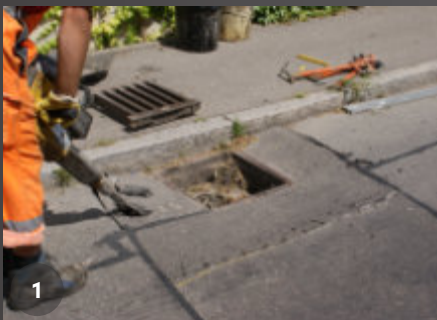
Straßenablauf/Neueinbau inkl. Asphaltteinbau
